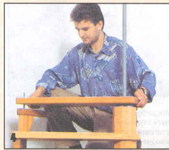
Выставляют вторую ступень и находящийся под ней элемент центральной стойки.
