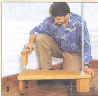
В нижнюю консоль ввинчивают шпильку и надевают на нее консоль первой ступени. На трубу центральной стойки накладывают вторую восьмигранник.
