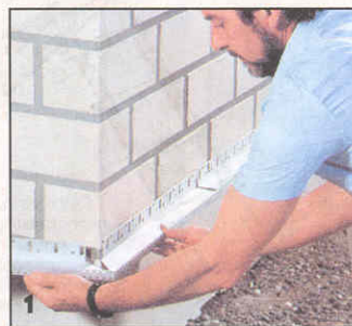
Цокольные профили, запиленные по торцам «на ус», выставляют с помощью подкладных шайб и крепят на специальных дюбелях.
