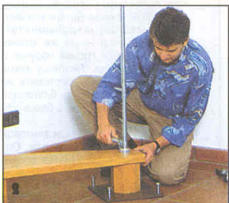
На трубу надевают центрирующее кольцо, восьмигранный элемент центральной стойки и первую ступень.
