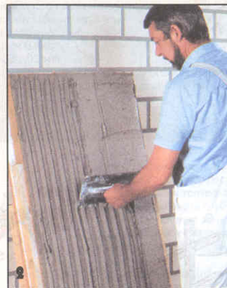
На изоляционную плиту наносят клей. При этом плиту опирают на доску, поставленную в ванночку для сбора стекающего клея.
