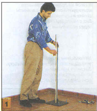
Трубу центральной стойки заранее скрепляют с помощью двух гаек с основанием. Последние прикручивают к полу.
